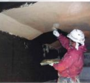
中塗り施工状況 タフガードQ-Rこて塗り
