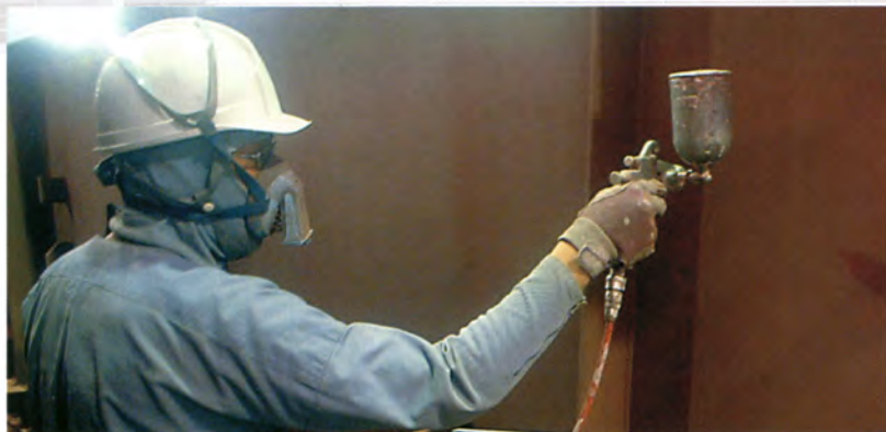
ハイボン導電プライマーの塗装↑
