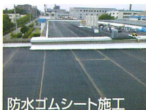
防水ゴムシート施工
